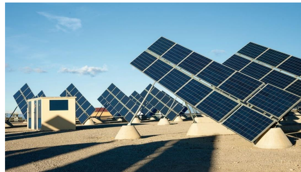
Photo 3 : Suiveurs à rotation bi-axiale (Source : PV Europe)
