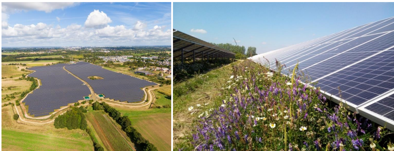
Photo 1 : Exemple d'installations fixes au sol : Centrale photovoltaïque de Bruz/Pont-Péan (Ferme Solaire Marc Energies, une réalisation IEL)
